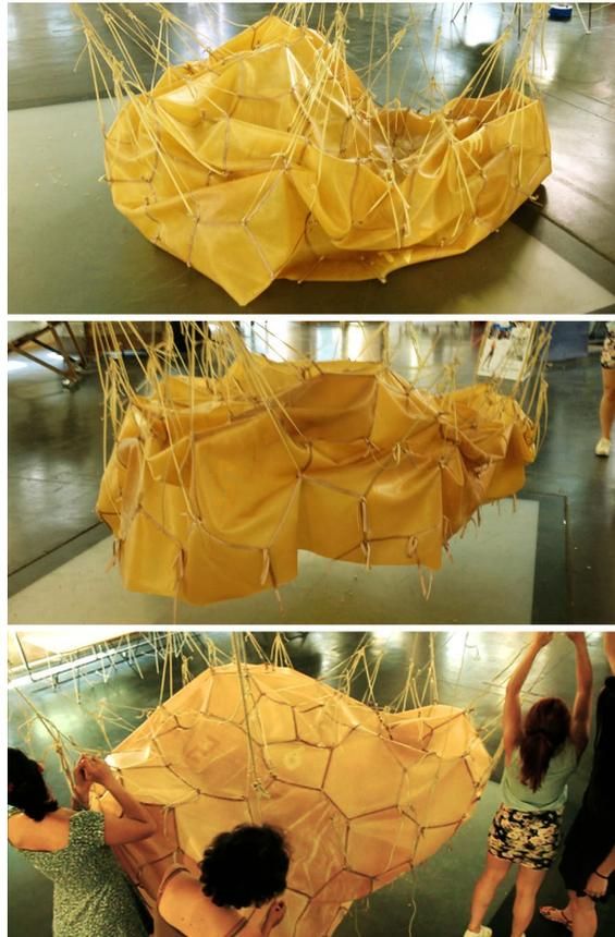
Fig. 3.3.2.18. Proceso de izado de la membrana y tensado de la estructura de venación traccionada.
