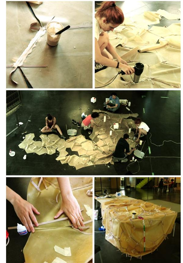
Fig. 3.3.2.16. Proceso de unión de las hileras entre sí. Se comienza utilizando el sistema de pegado de las cintas con látex encontrando dificultades debido al tiempo de secado y la imposibilidad de mantener la junta plana cuando se empiezan a generar las curvaturas de la membrana. Finalmente se opta por el pegado con adhesivo instantáneo (loctite) y agilizando enormemente proceso.
